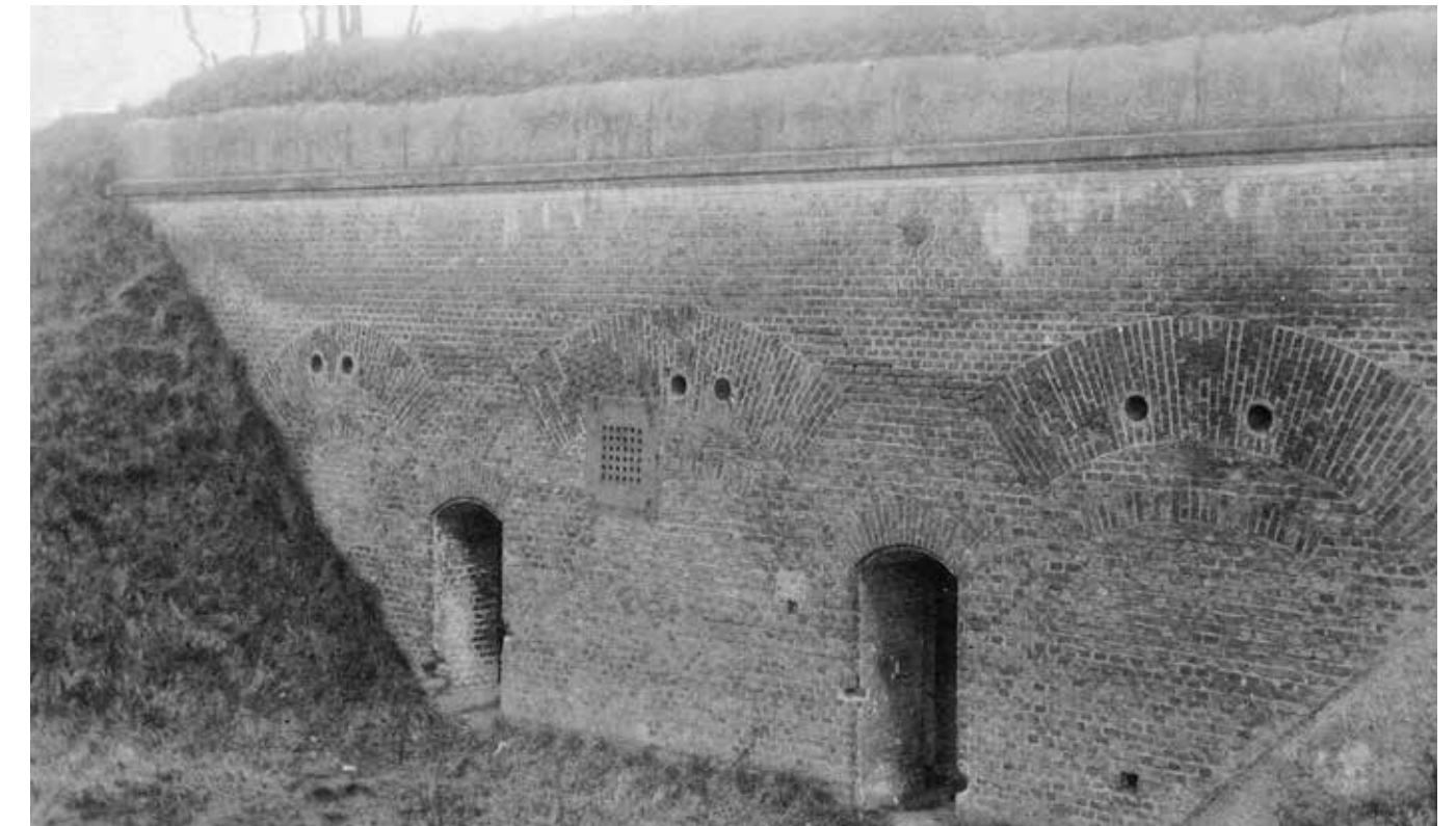
Artillerieraum 66 F: Das Gebäude war weitgehend im Boden eingelassen und mit einer dicken Betondecke geschützt. Dieses Bild wurde 1921 kurz vor der Sprengung aufgenommen. Foto: privat.
