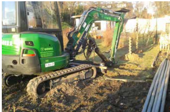
Bohrraupe: Die Sondierungsbohrungen wurden mit einer Bohrraupe durchgeführt. Rechts vorn liegen Bohrstangen, im Hintergrund auf der Wiese sind zwei Bohrschnecken zu erkennen. Sie fördern den Kies an die Oberfläche.
